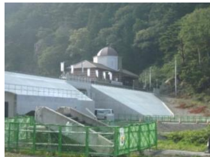
図2 島越駅付近の現在の様子。 震災前に周囲にあった観光施設と一体化させる形で駅舎の復旧が行われた。
