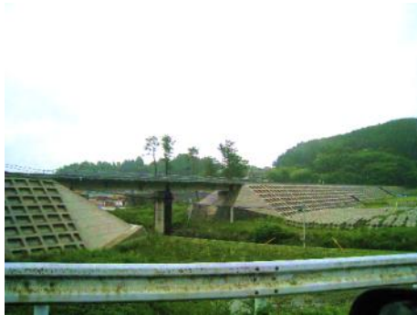
図5 事故発生地点付近の橋
