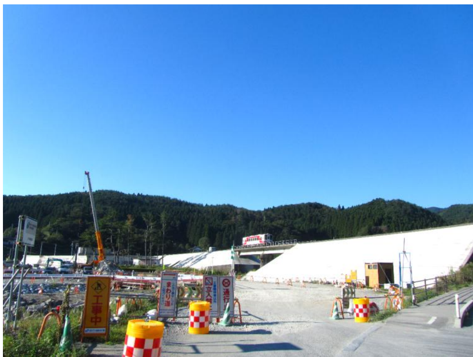
復旧が進む三陸 - 甫嶺間
