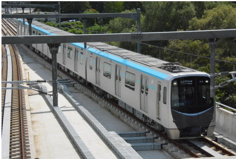
図3 試運転中の東西線2000系 大町西公園 - 国際センター間
