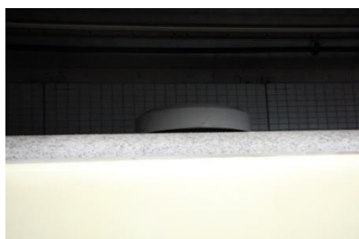
図6 1000系時代に設置されていた ベンチレーター
