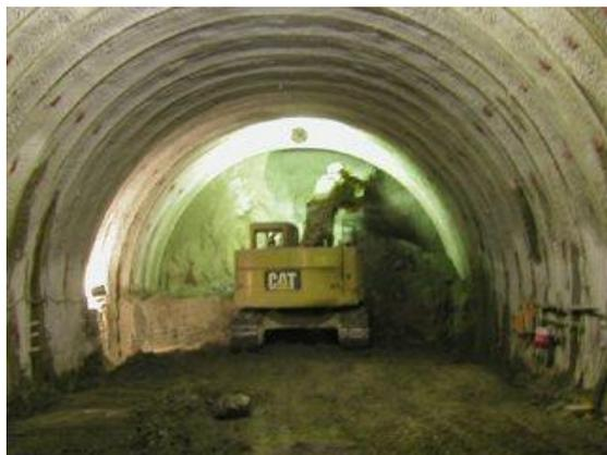
図4 NATM工法による青葉山トンネルの掘削の様子<sup>5</sup>
