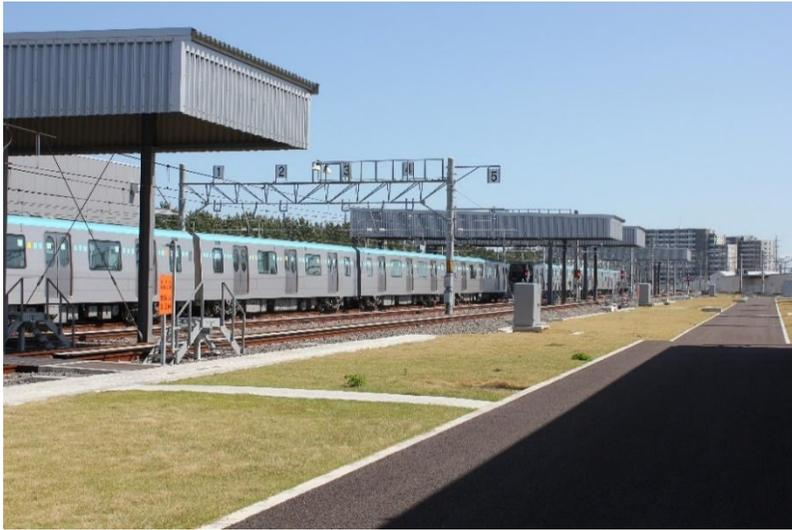
図4 集電装置上部に積雪対策の屋根が設置された留置線
