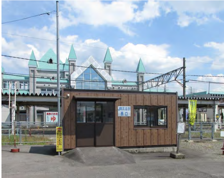
図1 西口の待合室(手前)と東口駅舎(後方)
