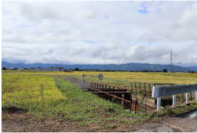
図23 現在の黒井堰 (写真中央の、一部がコンクリートに覆われた水路が黒井堰)
