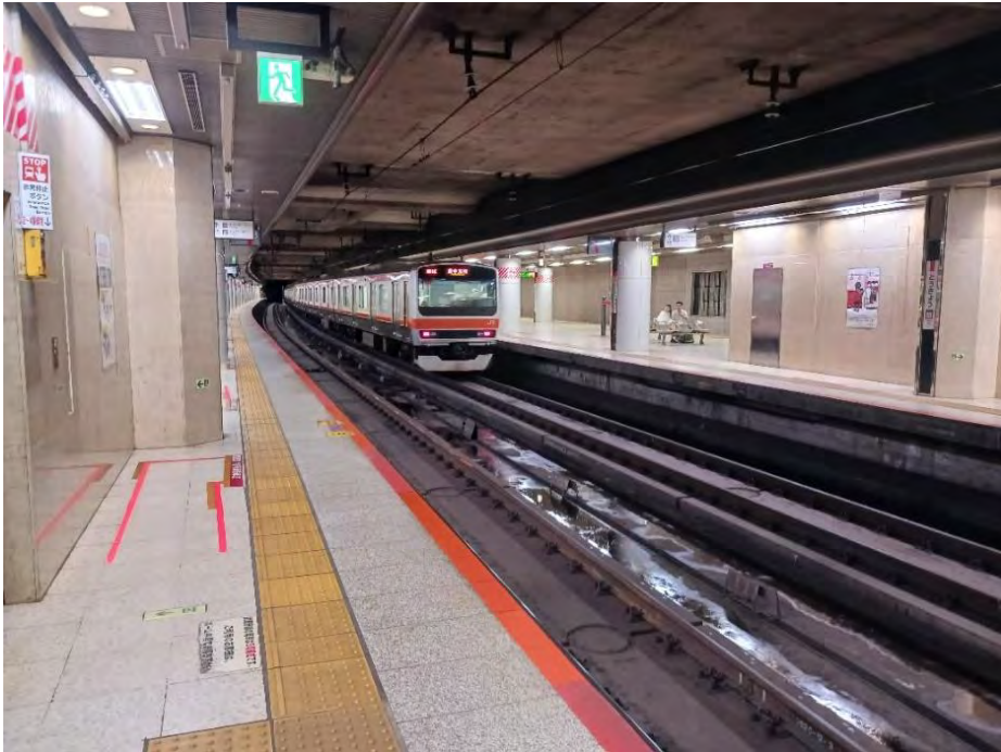
図19 JRの駅で日本一海拔が低いホーム；京葉線地下ホーム
