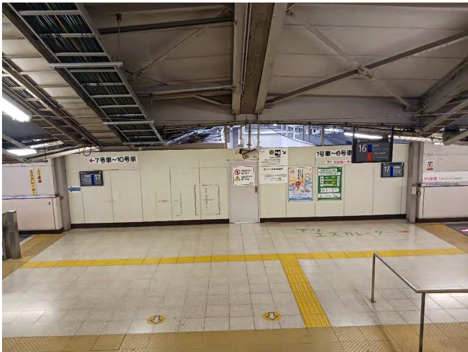
図4 旧18・19番線に通じる跨線橋の内部
