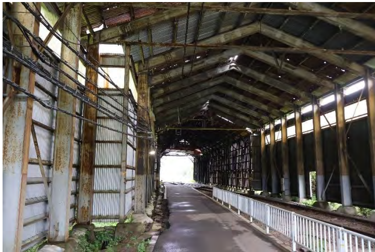
図7 板谷駅のスノーシェッド
