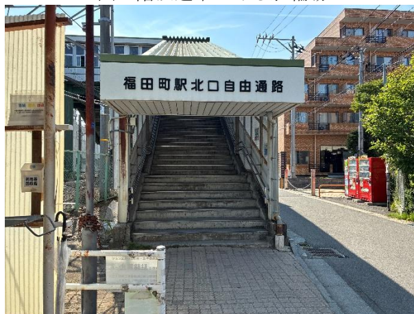
図2 スロープのない北口自由通路
