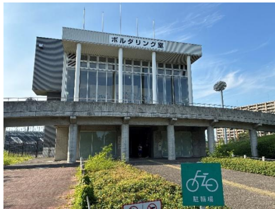
図3 仙台市新田東総合運動場内にあるボルダリング室
